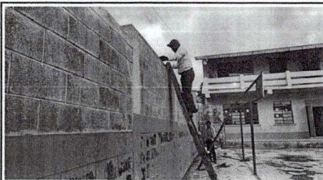
Foto 2: Sustitución de pintura exterior interior
