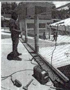
Foto 1: SUSTITUCION DE MAYA GALVANIZADA
