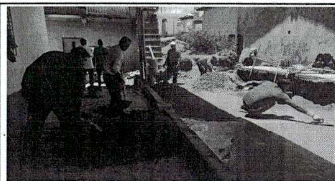
Foto 3: SUSTITUCION DE PISO DE CONCRETO
