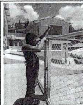
Foto 2: SUSTITUCION DE MAYA GALVANIZADA
