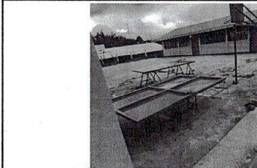
Foto 6: SUSTITUCION DE CHAPA Y REMOZAMIENTO DE PORTON LIJADO LIMPIEZA Y REMOSION DE ELEMENTOS CORRIDOS MAS PINTURA ANTICORROSIVA
