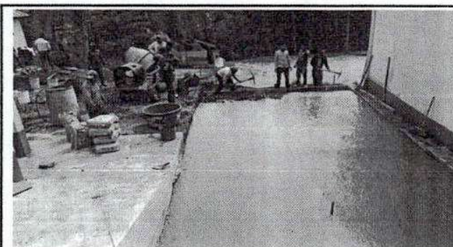
Foto 4: SUSTITUCION DE PISO DE CONCRETO
